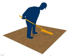
Finalizado el proceso de compactación, es necesario mantener la humedad de la superficie de la obra mediante lámina de plástico, arpillera húmeda, y/o riego pulverizado durante un mínimo de 1 semana. Siempre se cuidará de no lavar la superficie recién compactada.
