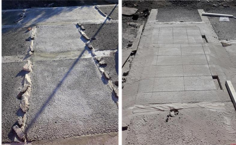
**Figura 3. Detalle de los pavimentos ejecutados y de la extracción de probetas para su estudio.**
