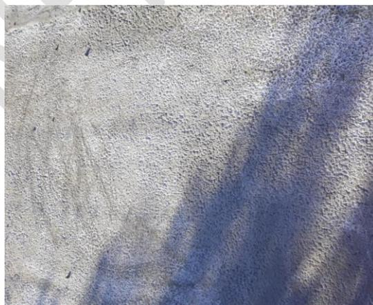
Figura 2. Aspecto del pavimento tras su percolación con i.tech CARGO.
